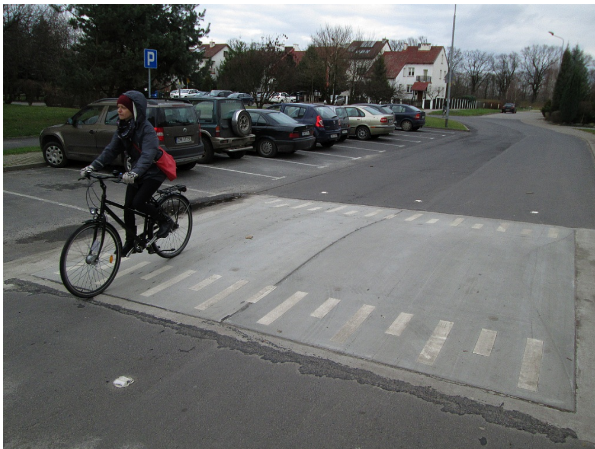
Fot. 1: Prefabrykowany płytowy próg zwalniający, optymalny z punktu widzenia ruchu rowerowego ze względu na obniżenia przy krawędzi jezdni (Wrocław).
