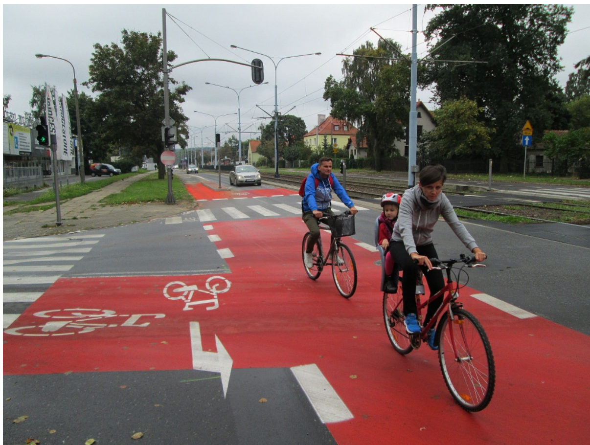
Fot 10. Śluza typu 2, Gdańsk, ul. Wojska Polskiego. W głębi widoczna na wlocie śluza klasyczna, typu 1. Uwaga: zdjęcie przedstawia rozwiązanie eksperymentalne (rok 2013), w niniejszych standardach proponuje się nieco inne oznakowanie poziome śluzy typu 2, zgodne z przepisami rozporządzenia w sprawie szczegółowych warunków technicznych dla znaków i sygnałów drogowych oraz urządzeń bezpieczeństwa ruchu drogowego i warunków ich umieszczania na drogach po nowelizacji z 2015 roku.
