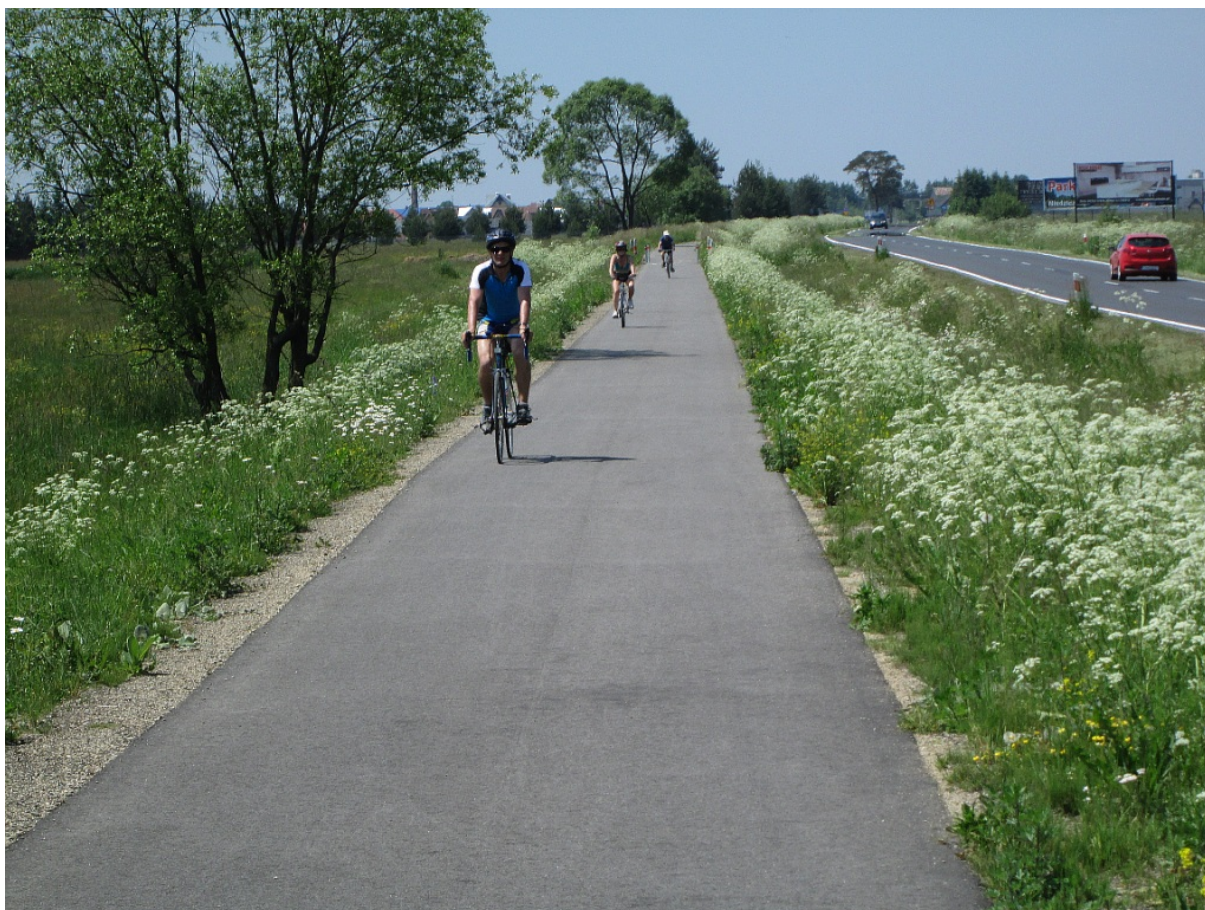
Fot 6. Droga dla rowerów o nawierzchni asfaltowej wykonana na poszerzonej podbudowie, bez zbędnych i podnoszących koszty obrzeży lub krawężników. Droga wojewódzka nr 957, fragment trasy rowerowej euroregionu Tatry Nowy Targ – Sucha Hora/Trstena (Słowacja).
