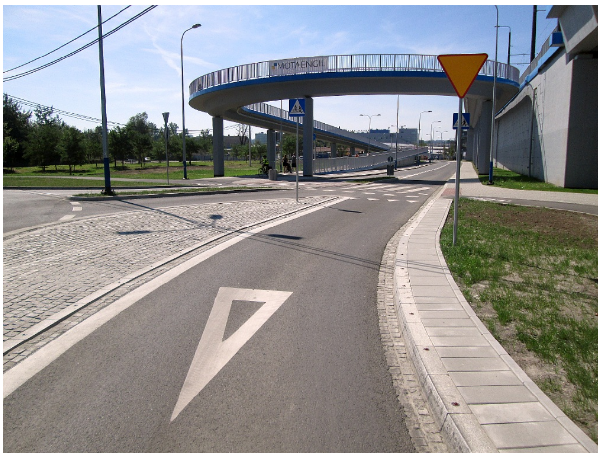
Fot. 12. Poprawne oznakowanie przejazdu dla rowerzystów przecinającego łącznicę („bypass”). Za znakiem poziomym P-15 i pionowym A-7 widać znak D-6b który nie ustala pierwszeństwa i jest jedynie znakiem informacyjnym. Przed przejazdem dla rowerzystów wyznaczono linię zatrzymań złożoną z trójkątów (P-13). Kraków, ul. Saska.
