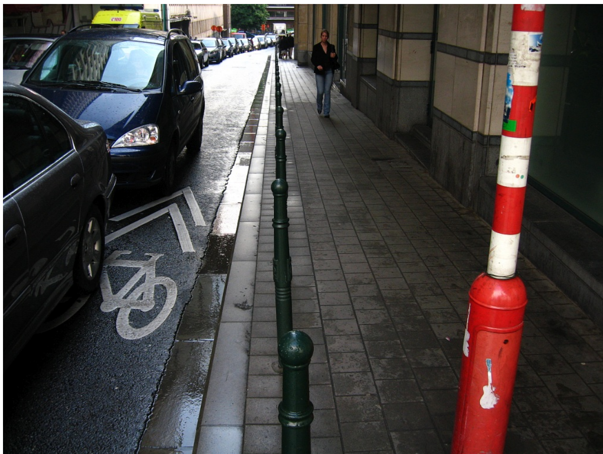
Fot 3. Odpowiednik znaku P-27 „kierunek i tor ruchu roweru” w jezdni ulicy jednokierunkowej, otwartej dla ruchu rowerowego w obu kierunkach. Bruksela, Belgia.
