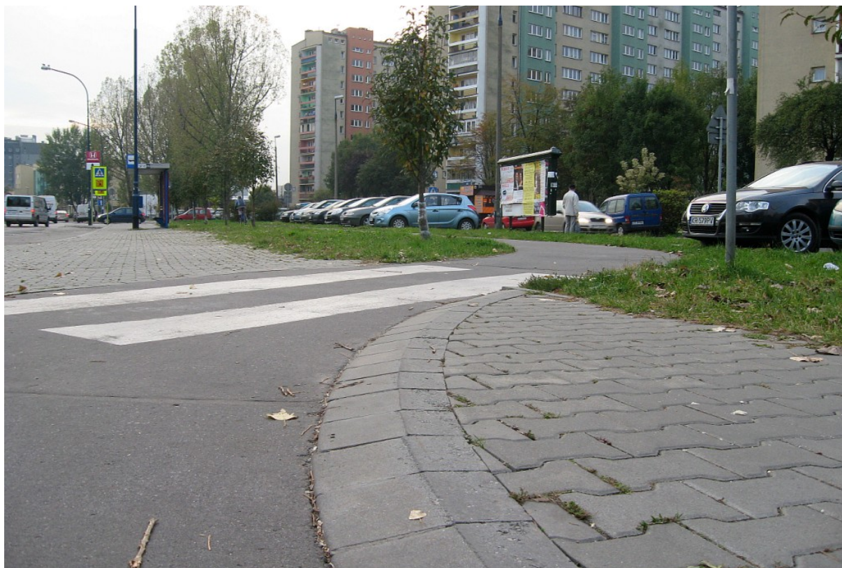
Fot. 5. Prawidłowe oddzielenie drogi dla rowerów od przylegającego chodnika położonym na płasko krawężnikiem drogowym, tworzącym skos ok. 15-30 stopni przy obniżeniu niwelety drogi dla rowerów wobec chodnika o 3-5 cm. Ul. Marii Dąbrowskiej, Kraków.
