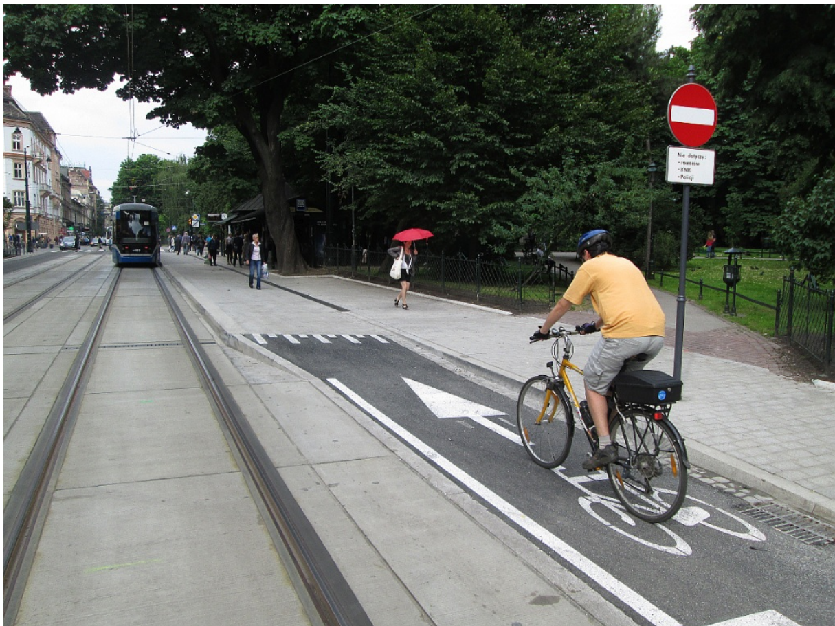
Fot. 4. „Przystanek wiedeński” zlokalizowany w przedłużeniu pasa ruchu dla rowerów (kontrapasa). Ze względu na wspólny ruch tramwajów i autobusów zastosowano krawężnik typu „kassel” umożliwiający bezpieczny dojazd autobusu do krawędzi. Kraków, ul. Podwale.
